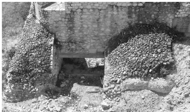
Fig. 4 – Teatro: aditus meridionale. In evidenza lo spessore del muro occidentale (a ds.) dovuto all'integrazione del terreno nella struttura.
