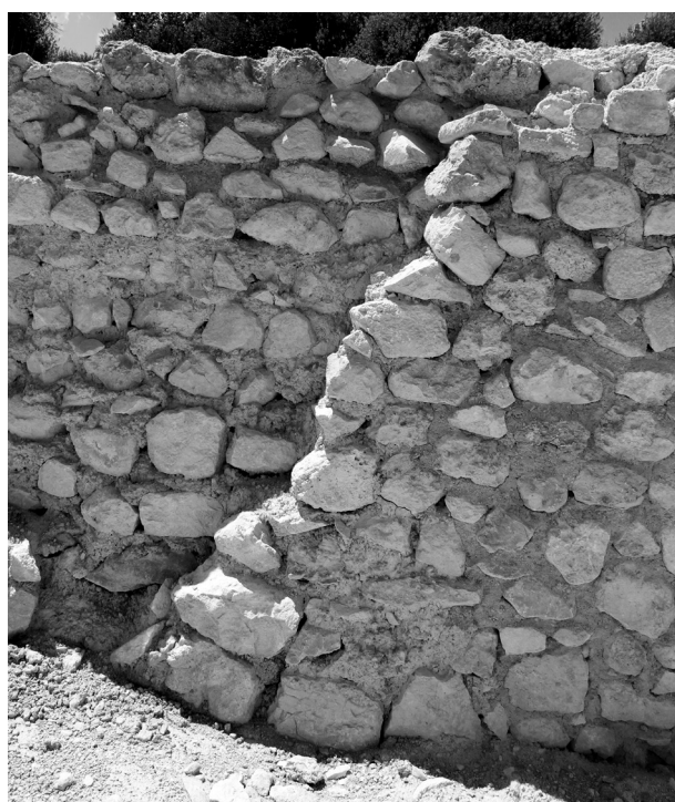
Fig. 19 – Ambiente δ: il muro ovest segue la pendenza del terreno da sud verso nord. In evidenza anche la doppia struttura della parete.
