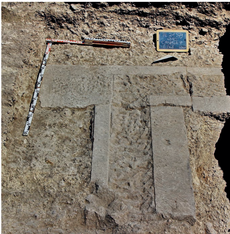
Fig. 20. Peltuimum , foro: settore ovest. Dettaglio del canale di 1a fase con lavorazione a sabbia interrotta
