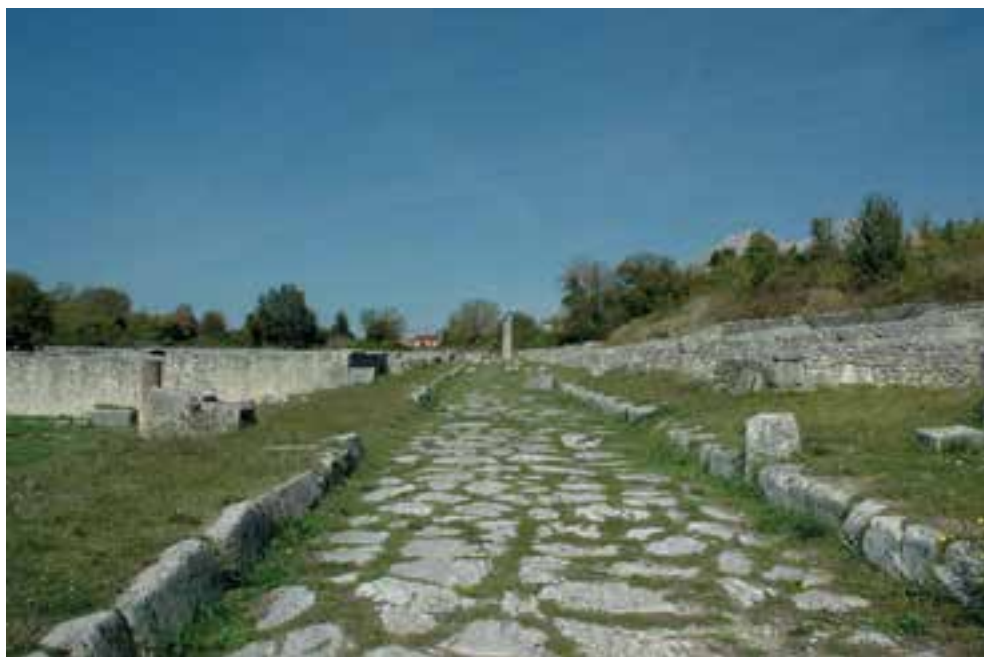
8. Alba Fucens . Pavimentazione stradale in calcare. Via dei Pilastri (foto autore)
